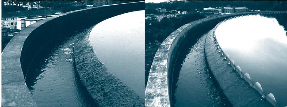
Figura 2.27 – Dispositivo inadequado de entrada de água floculada no decantador, provocando quebra de flocos
