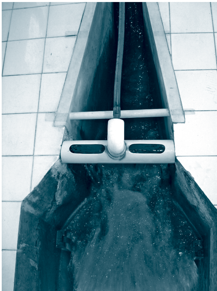
Figura 2.20 – Detalhe de dispositivo adequado de aplicação do coagulante com difusores de simples execução
