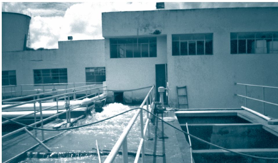
Figura 2.22 – Exemplo de unidade com funcionamento inadequado de floclador: excesso de vazão e transbordamento nas câmaras de floclação
