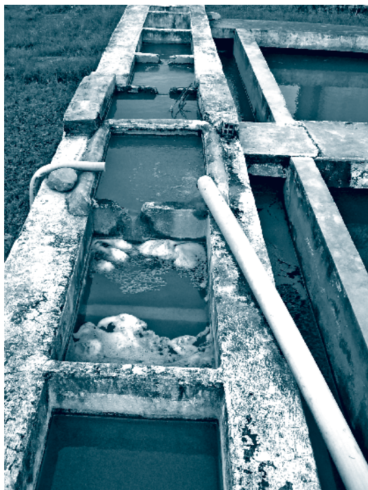
Figura 2.22 – Exemplo de unidade com funcionamento inadequado de floclador: excesso de vazão e transbordamento nas câmaras de floclação
