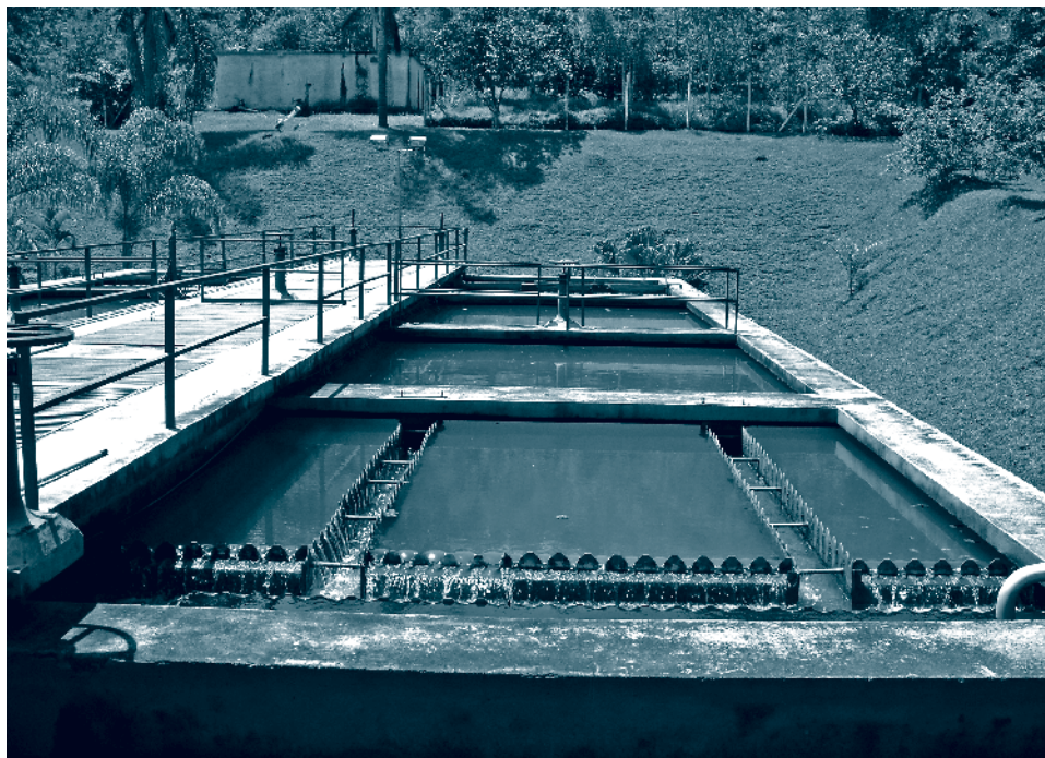
Figura 2.24 – Decantador convencional com escoamento horizontal
