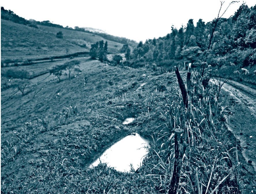
Figura 2.5 – Pequena bacia de infiltração de enxurrada proveniente de estrada de terra (observar a lombada feita na estrada para o desvio da enxurrada)
